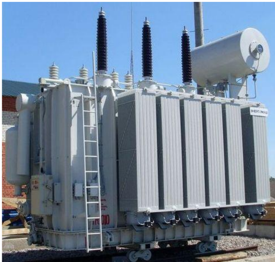
Трёхфазный трансформатор с масляной изоляцией 110/35/27,5 кВ
