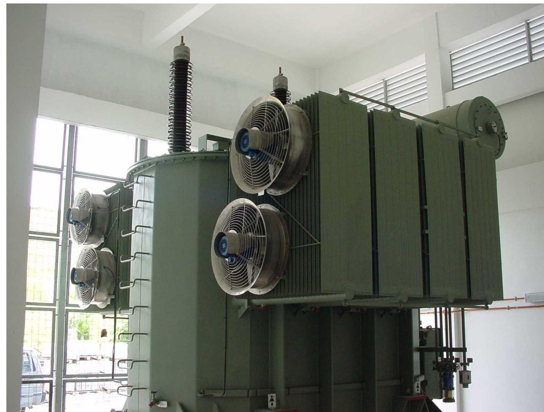
Однофазный тяговый трансформатор с масляной изоляцией 110/27,5 кВ
